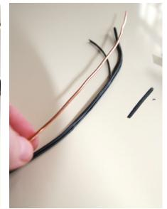
1/ Dénudez le cable électrique en enlevant le plastique qui l'entoure à l'aide du cutteur en effectuant toujours un mouvement de vous en direction de l'extérieur (jamais vers l'intérieur ou vous pourriez vous blesser avec le cutteur en cas de dérapage de la lame)
