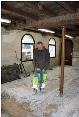
En effet notre ami Didier a entrepris de démolir la dalle en béton mise en place par nos anciens, au-dessus des bacs et des dalles de pierre.
