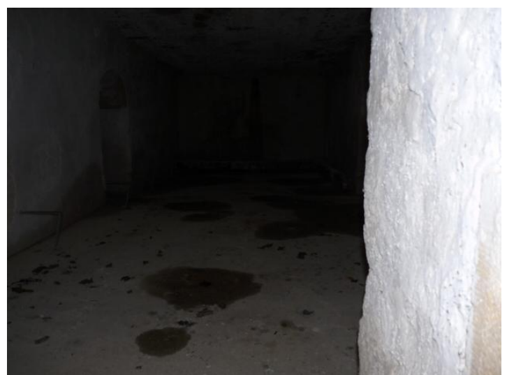
Intérieur d'un ouvrage, Chemin de relève à Verdun.
