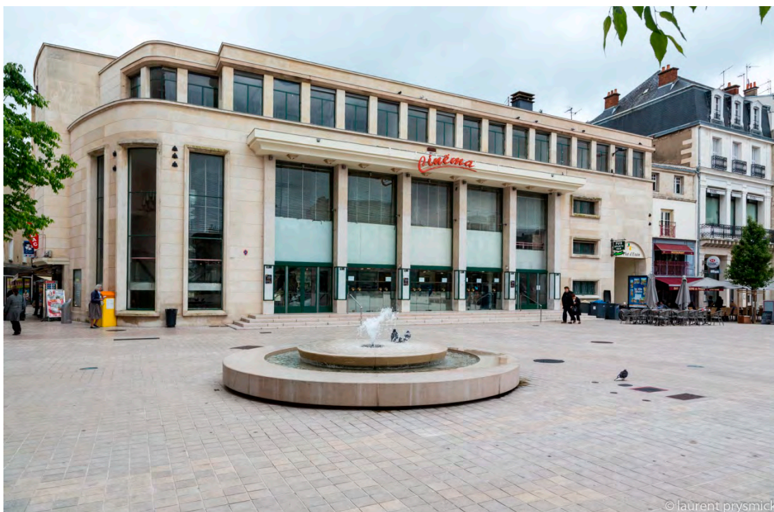
La façade de l'ancien théâtre municipal sur la place de l'hôtel de ville
